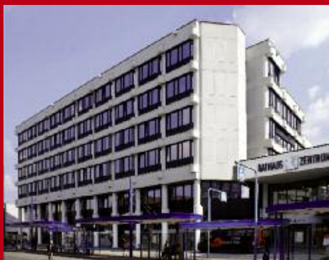
Teilansicht des Gebäudes von der Matthiasstraße nach der Sanierung.
