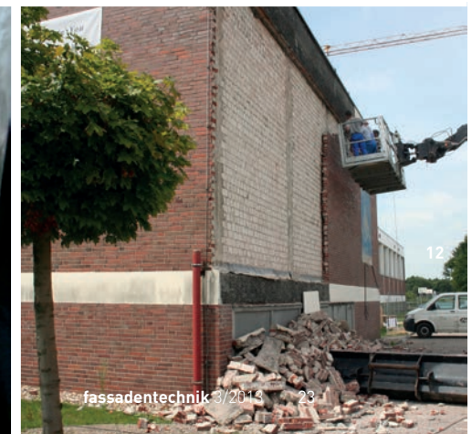
Wenn der Zwischenraum einer Klinkerwand keine ausreichende nachträgliche Dämmung zulässt, bleibt häufig nur der Abriss.
