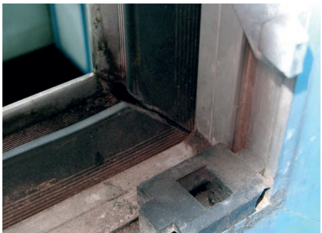
Typisches Bild alter Fenster: Offene Dichtungen innen ...
